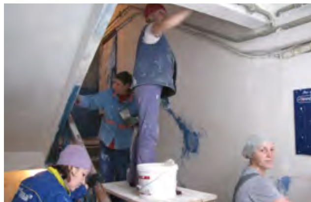
К 45-летию дома ул. Ленина, 36 управляющая компания «ТВМ» отремонтировала все 8 подъездов
