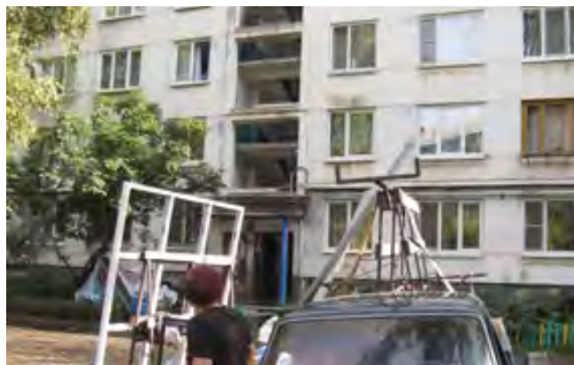
В домах УК «Чайковская» идут массовые капремонты. Собственники осваивают средства, накопленные на спецсчетах, пример тому — капремонт крылец и подходов дорожек ул. Советская, 5 и ремонт фасада (замена оконных блоков) на ул.К.Маркса, 2
